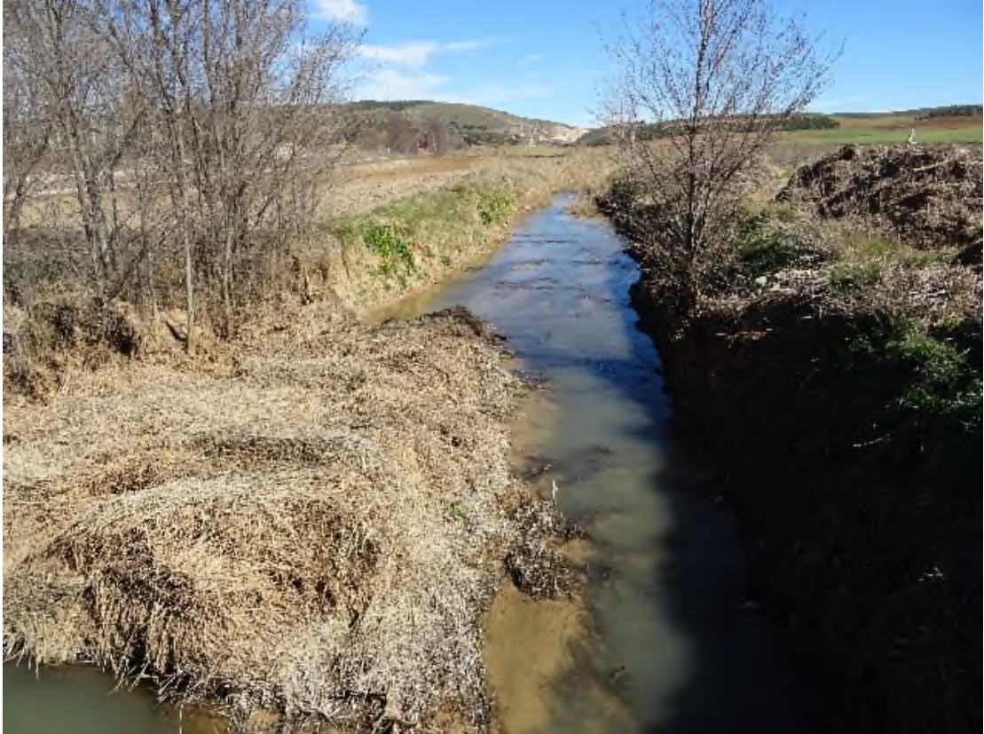
Fotografía 18. Alteración de la morfología natural del cauce y de sus riberas en el río Riansares, Tarancón.
