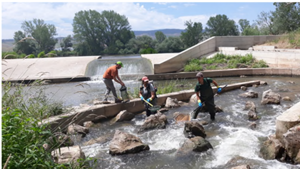
Fotografía 28. Trabajos de seguimiento en un sistema de paso para peces de tipo rampa mediante su evaluación biológica.
