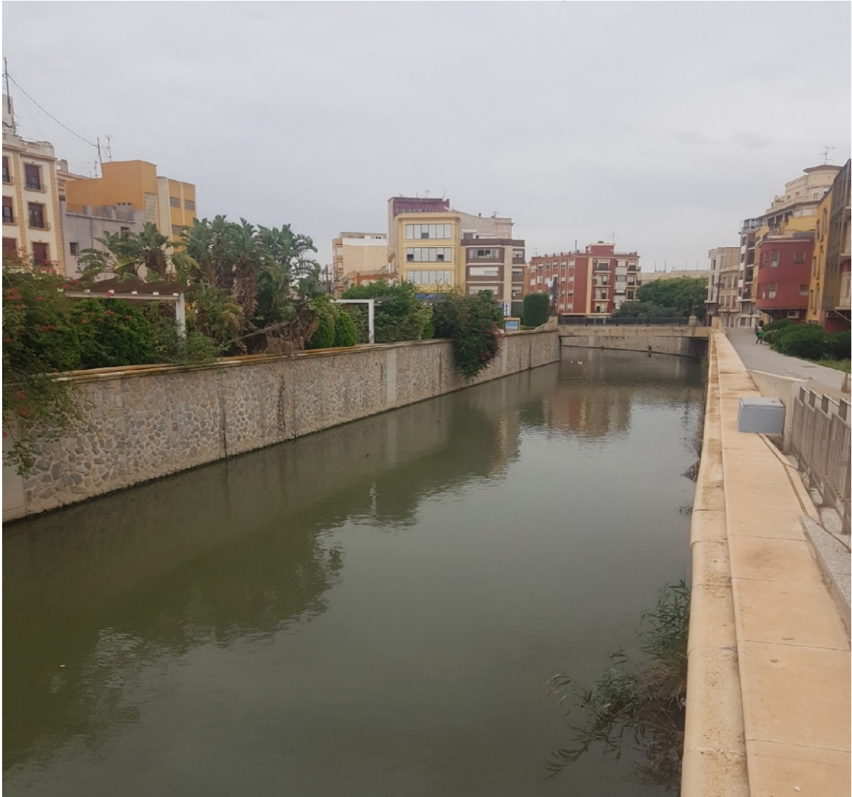
Fotografía 12. Alteraciones geomorfológicas. Modificación de la morfología natural del cauce en el río Segura.
