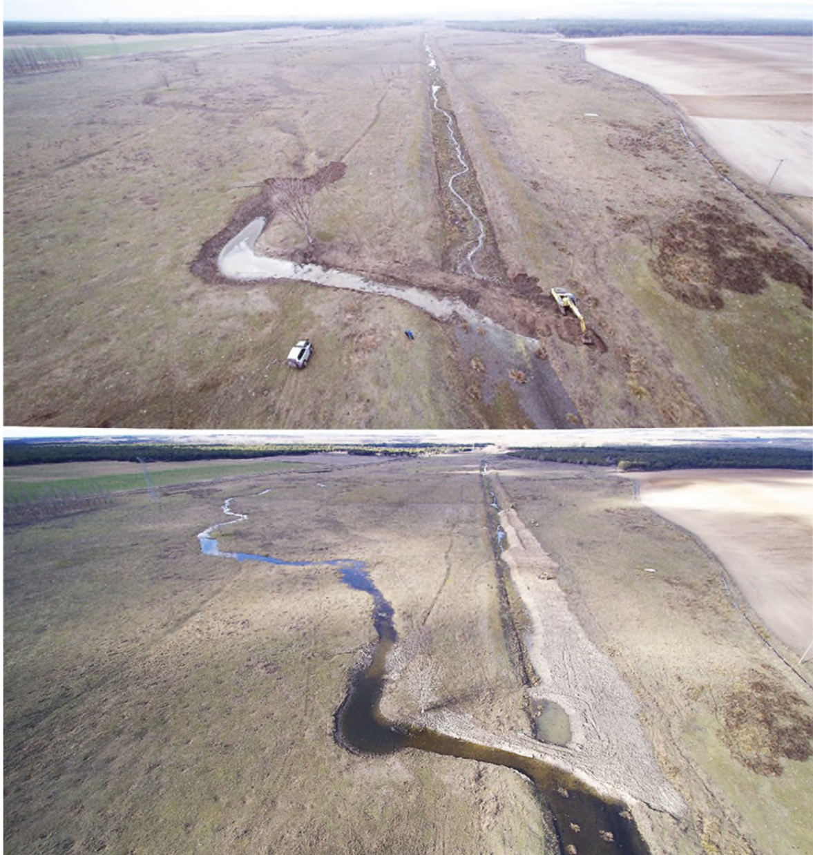
Fotografía 8. Actuación de recuperación del trazado natural en un tramo rectificad del río Zapardiel. Inicio de las obras (arriba) y conexión del trazado antiguo tras las obras (abajo).
