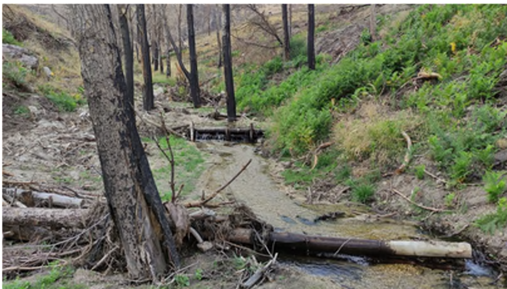
Fotografía 25. Albarradas para el control de la erosión en un cauce afectado por el incendio forestal de La Paramera, Ávila (2021).
