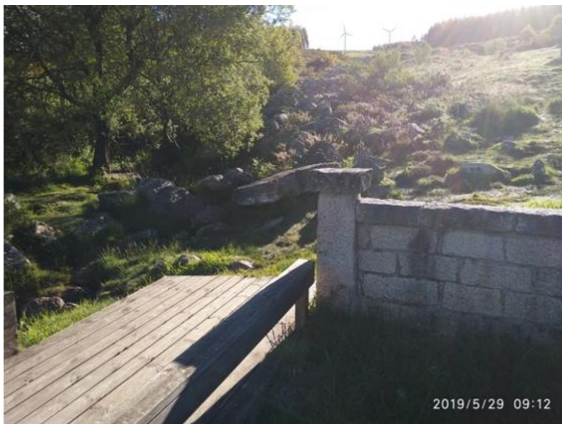
Vista del final del canchal encajado donde ya se puede ver discurrir el agua.
