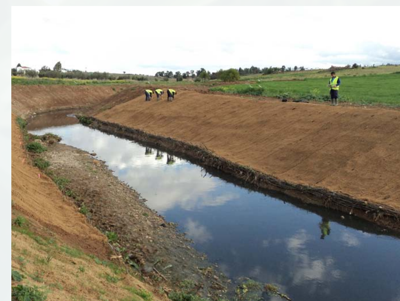
Figura 9. Recubrimiento con red de coco y plantaciones.
