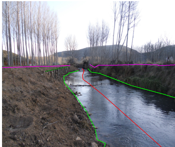
Figura 10. Imagen de las líneas de rotura tomadas para definir la geometría del cauce
