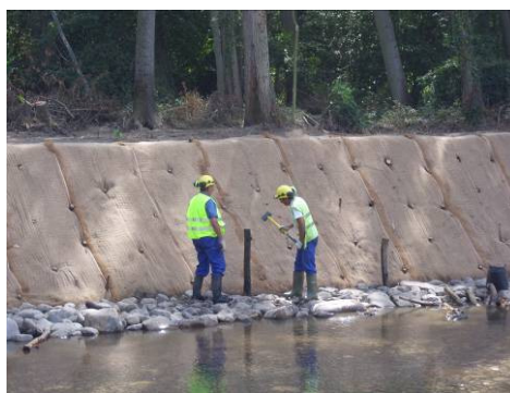
Figura2. Imagen de ejecución de escollera vegetada y geomalla
