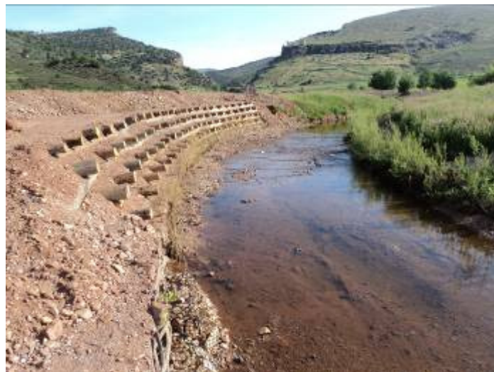
Figura 2. Muro krainer ejecutado
