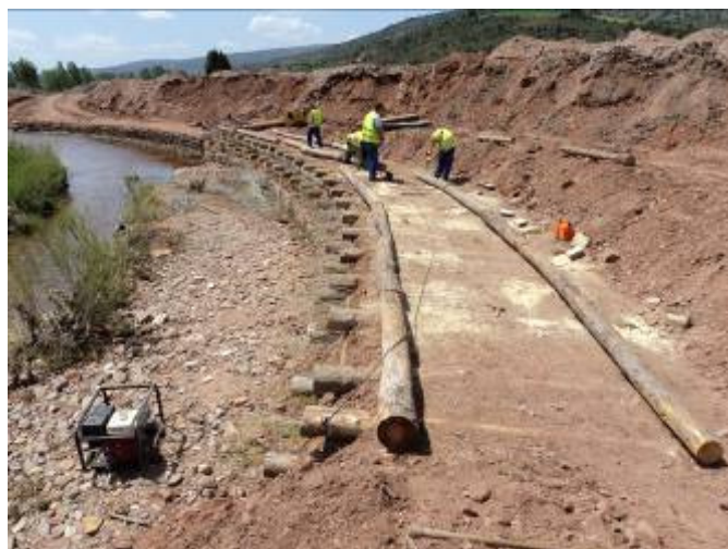
Figura 4. Operarios colocando troncos en un plano del muro Krainer.
