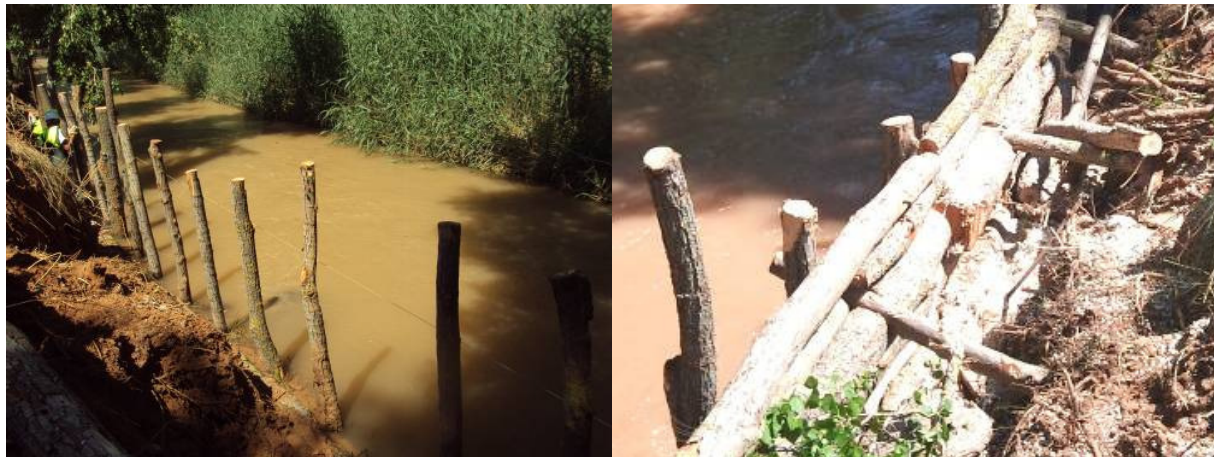
Figuras 7 y 8. Colocación de postes verticales (izqda.) y colocación de postes longitudinales y transversales (dcha.)
