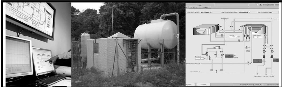
***Telecontrol: sistema automático de toma de datos de una red de servicios y envío telemático de estos a una Centro de Control y a los responsables de guardia. Cortesía de SOCADE.***
