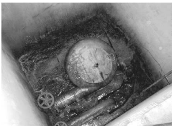
Figura 15. Fotografía dun vortex instalado en cámara seca (esquerda) e esquema da curva de gasto destes dispositivos (dereita).
