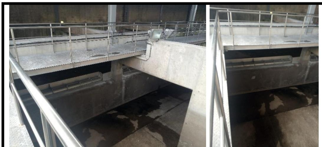
***Tamices rotativos instalados entre la Cámara central y las Cámaras de retención en el Aliviadero Oviedo Sur (o Tanque de Tormentas Oviedo Sur). Cuenca del río Nora en Oviedo (Asturias). Cortesía del Consorcio de Aguas de Asturias (CADASA). Gobierno del Principado de Asturias.***
