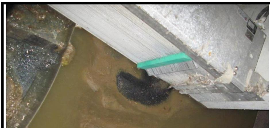
***Red primaria de saneamiento del Consorcio de Aguas Bilbao Bizkaia. Tamiz lateral sobre vertedero. Instalado paralelo y encima del propio vertedero. Filtra de arriba hacia abajo. La limpieza se realiza mediante un peine con sentido de izquierda a derecha. Posibilidad de rebose por encima. Cuenta con una sonda de nivel que se activa a partir de cierta cota. Cortesía del Consorcio de Aguas Bilbao Bizkaia (CABB).***
