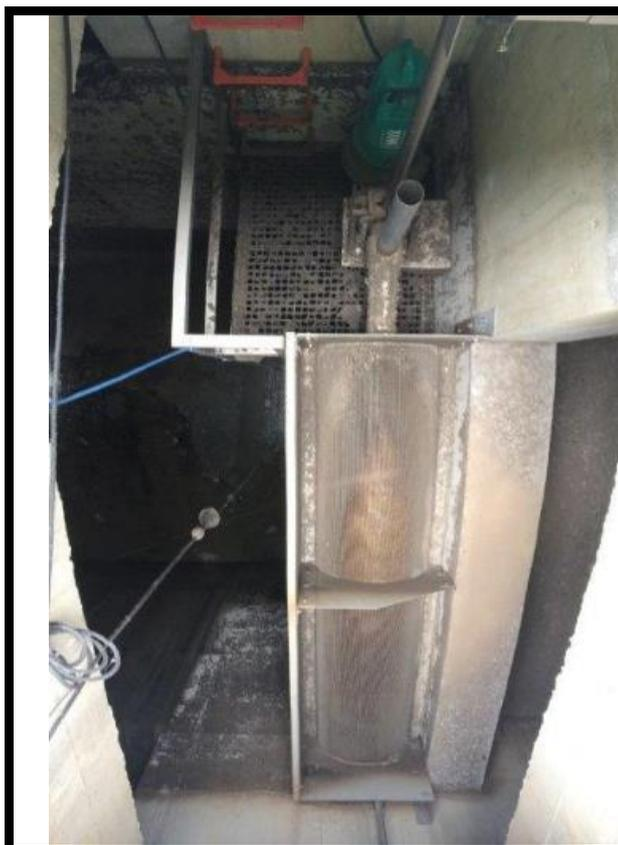
**Red primaria de saneamiento del Consorcio de Aguas Bilbao Bizkaia. Tamiz horizontal de chapa perforada (4-10 mm) instalado antes y en paralelo al vertedero. Filtra de abajo hacia arriba. La limpieza se realiza recirculando agua del propio pozo mediante un sistema de aireación y agitación (bomba airjet). Posibilidad de rebose por encima. Cuenta con una sonda de nivel que se activa a partir de cierta cota. Cortesía del Consorcio de Aguas Bilbao Bizkaia (CABB).**
