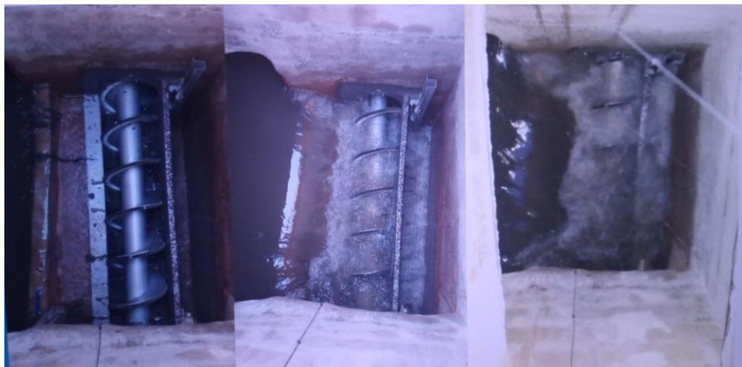
***Tamiz en espiral instalado en el aliviadero Río Seco del sistema de saneamiento de Castellón. Malla de paso de 10 mm, 2,10 m de largo y 0,5 m de diámetro. El tornillo sin fin dispone de unas escobillas que retiran los sólidos de la malla de paso y los conduce a otra arqueta independiente. En dicha arqueta se retiran los sólidos mediante camión cuba. Cortesía del Ayuntamiento de Castellón.***
