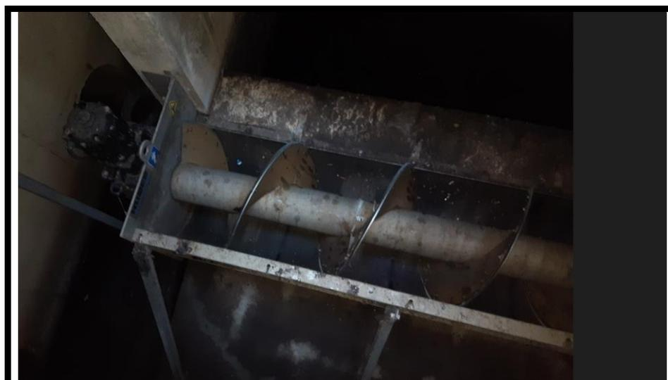
**Red primaria de saneamiento del Consorcio de Aguas Bilbao Bizkaia. Tamiz horizontal de chapa perforada con tornillo helicoidal para sacar material de entre 6-10 mm. Instalado por detrás del vertedero y en paralelo. Filtra de arriba hacia abajo. La limpieza se realiza recirculando agua del propio pozo mediante un helicoidal. Posibilidad de rebose por encima. Cuenta con una sonda de nivel que se activa a partir de cierta cota. Cortesía del Consorcio de Aguas Bilbao Bizkaia (CABB).**
