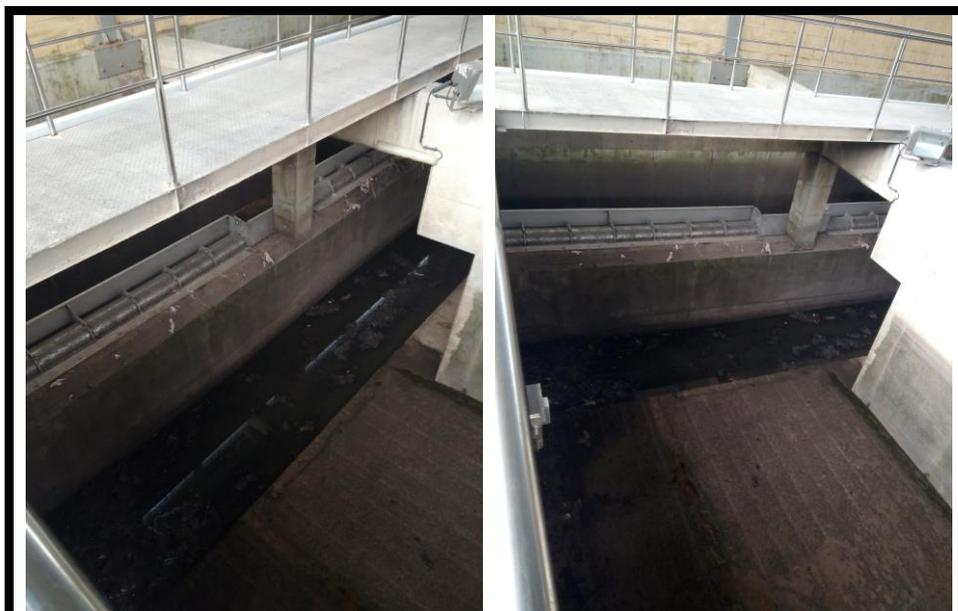
***Tanque de Tormentas Fluyente Off-Line. Tamices rotativos en el Aliviadero Oviedo Norte (o Tanque de Tormentas Oviedo Norte) entre la Cámara central y las Cámaras de retención. Cortesía del Consorcio de Aguas de Asturias (CADASA). Gobierno del Principado de Asturias.***
