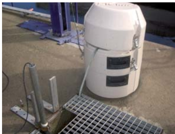
Muestreador en continuo para la obtención de muestras compuestas (Foto G. Espinosa)
