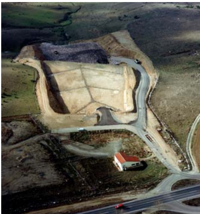
Vertedero de residuos sólidos urbanos en el que puede apreciarse la red de recogida de lixiviados (MMA)
