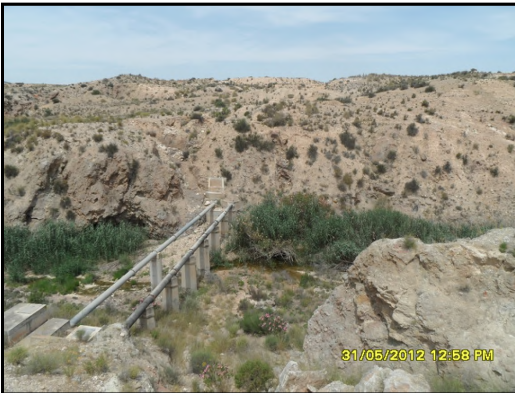
Cruce rambla del Carrizalejo e infraestructuras existentes.
