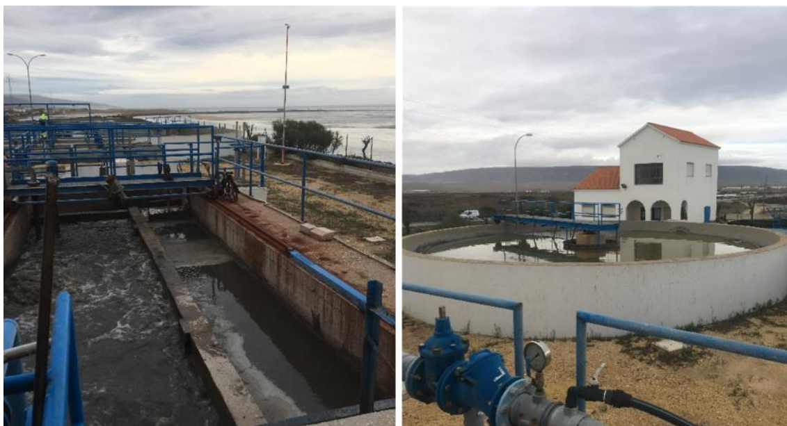
Ilustración 3: Desarenado – desengrasado (izquierda), Vista decantador y edificio de control (derecha).
