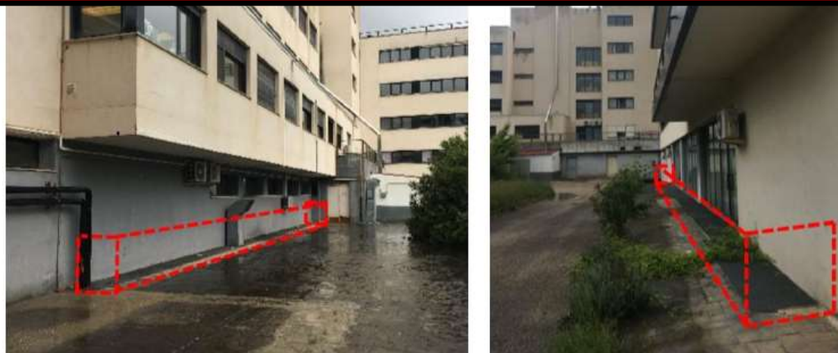
Fig. 25 Murete de protección de rejilla hospital y residencia.
