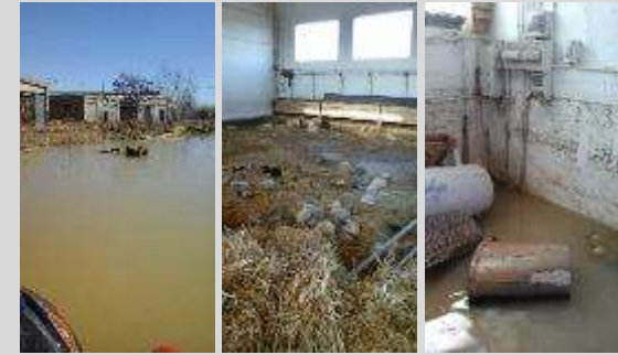
Bajas de animales, daños en naves por entrada de lodos y parada de actividad durante dos meses
