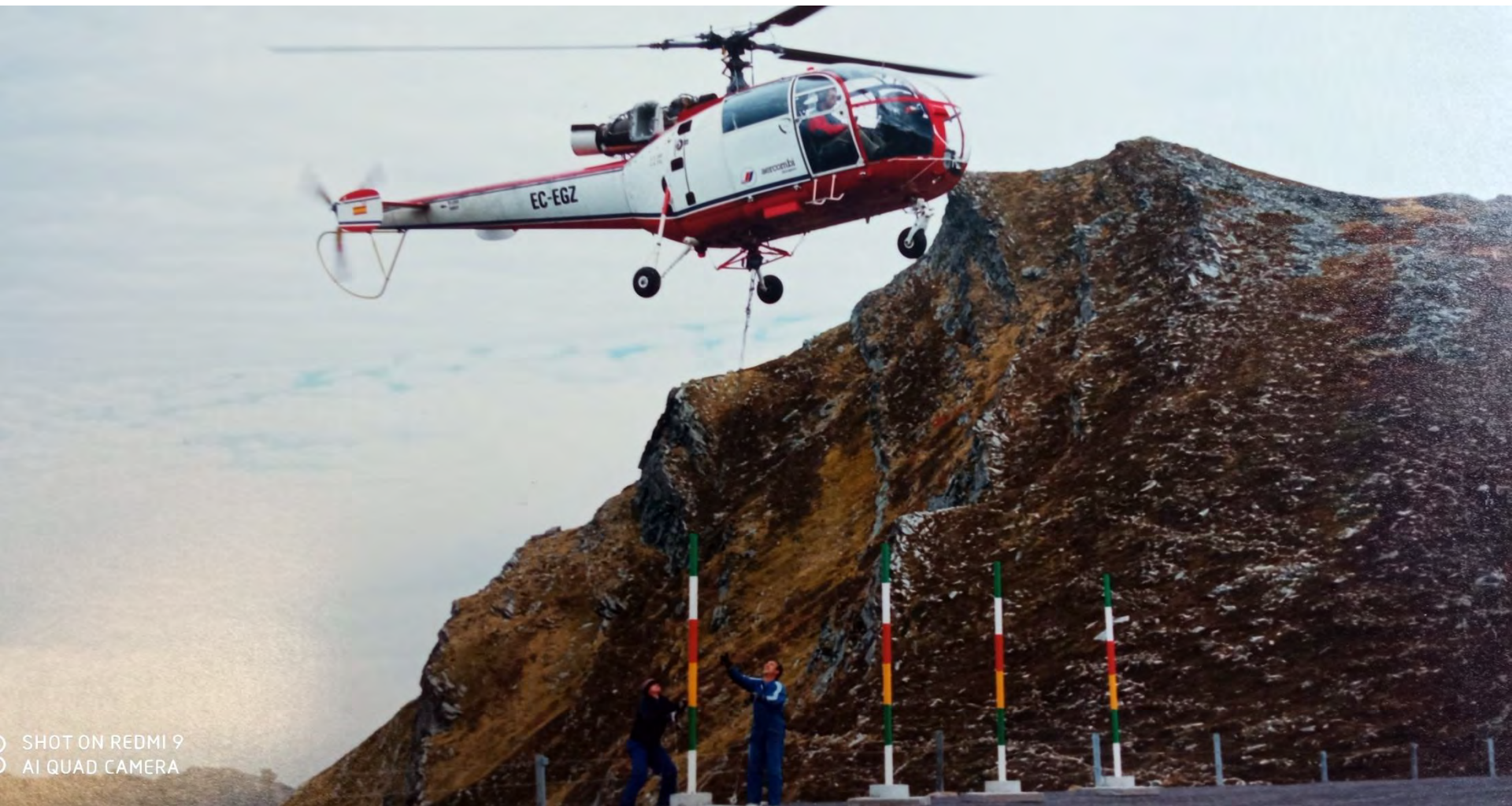
Instalando las pértigas de la Cantábrica 1992
