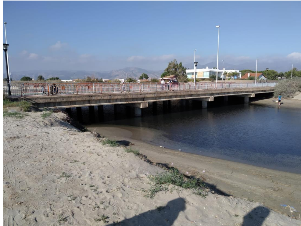
Desembocadura: puente de la carretera CV-1501
